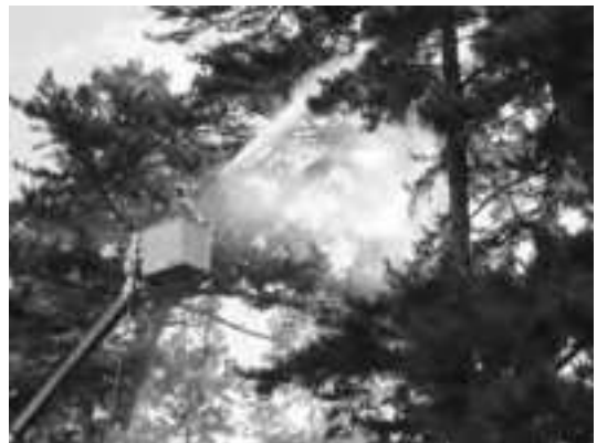
写真 3 B 高所作業車の上からの薬剤散布作業
