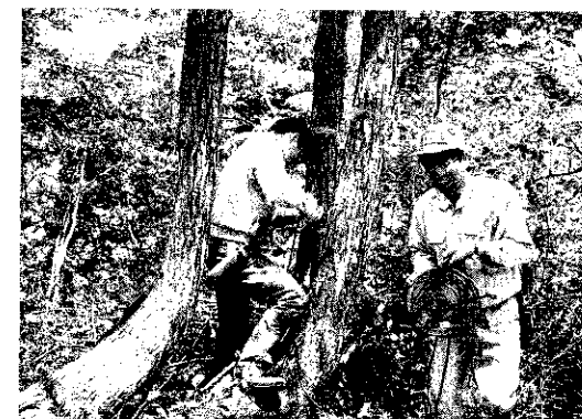
写真一 従来型の注入孔のドリル穿孔。動力は発電機で電気ドリル使用なので、重くコードがからみ作業が困難
