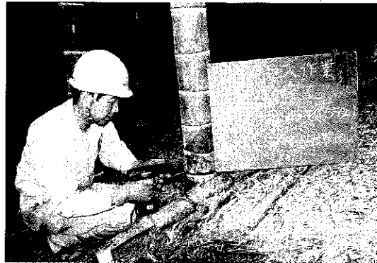
写真一七 電動ドリルで竹稈に穿孔する
