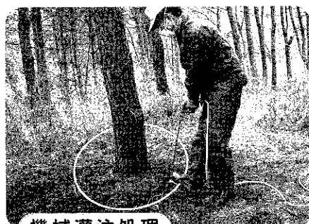
機械灌注処理
