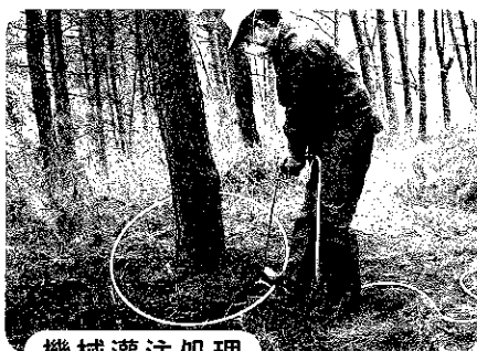
機械灌注処理
